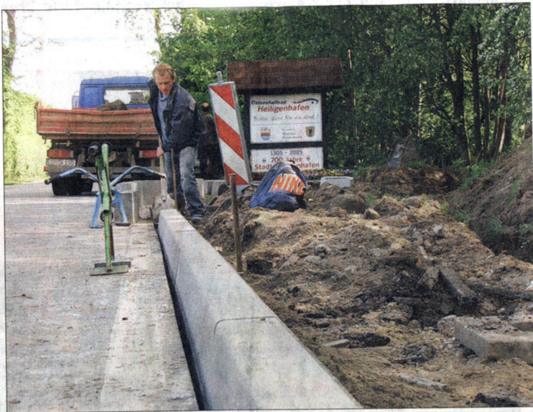
Der Bordstein ist bereits gesetzt: Daniel König von der Heiligenhafener Firma Ruschau bei der Arbeit am neuen Gehweg. Foto: MK
